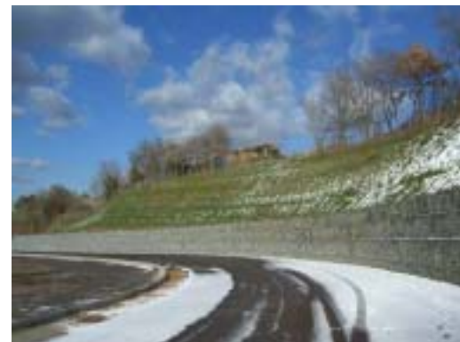
Il cantiere a febbraio 2006
