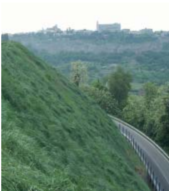
La scarpata consolidata e rinverdita a maggio 2006
