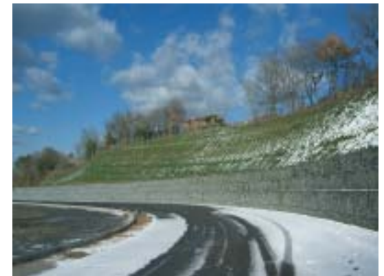
Il cantiere a febbraio 2006
