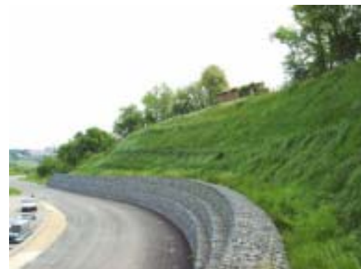
La scarpata consolidata e rinverdita a maggio 2006
