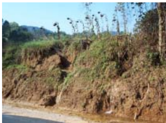
Erosione e smottamenti sulla sede stradale causata dalla coltivazione di piante annuali fino a bordo strada
