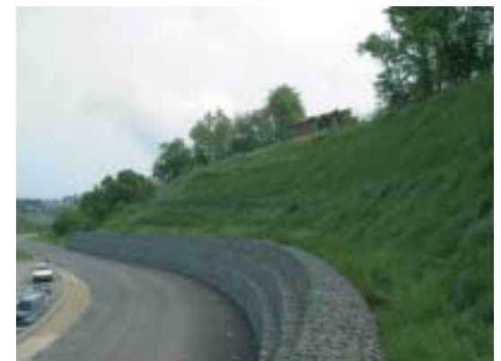
La scarpata consolidata e rinverdita a maggio 2006
